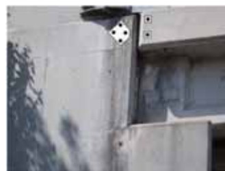
写真-5 伸縮装置移動量計測 (イメージ)
