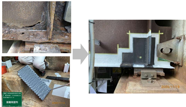
CFRP成形板接着工法
