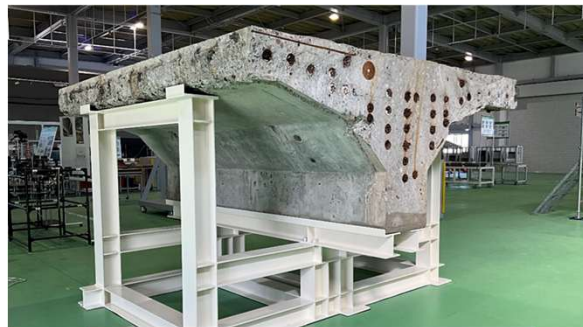
老朽化した橋梁から切り出した実物供試体
