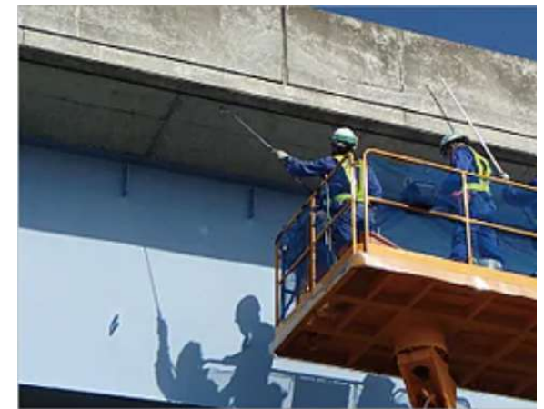
製品例 E-inspection 333eye 回転式打音点検器 金属製多面体装置を転がすだけで点検が可能です
